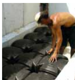
Posa gutta drytek®
