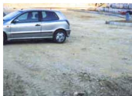
Fig. 1 Sottofondo ben compattato prima della posa di guttagarden®.
