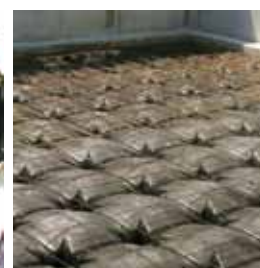
Posa gutta drytek®
