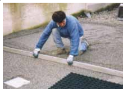
Fig. 2 Staggiatura e preparazione del fondo.
