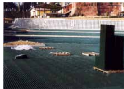
Fig. 3 Superficie durante la posa.
